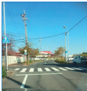
長須賀学区で横断歩道を新設
